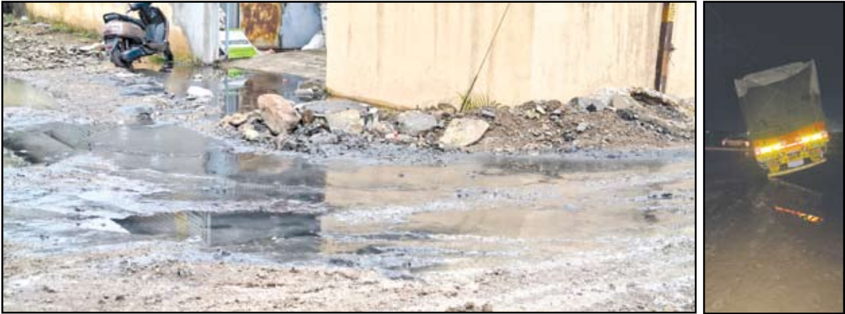
इंडस्ट्रियल इस्टेट परिसरात सुरु असलेल्या ड्रेनेज लाईनच्या अपूर्ण आणि अर्धवट कामामुळे संपूर्ण वसाहतीत चिखलाचे साम्राज्य निर्माण झाले आहे.
